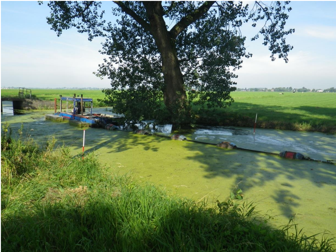
Afbeelding 2. Baggeren met cutterzuiger in veenweidegebied
